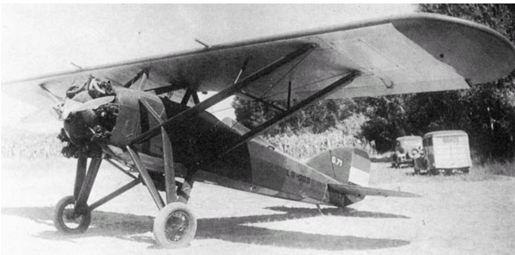
Un GL-32 de una serie que ya tiene patas independientes en el tren de aterrizaje.
