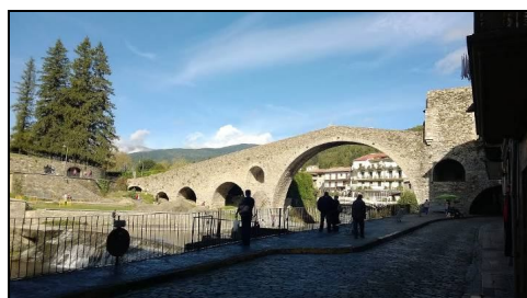
Puente medieval de Camprodón (imagen actual).
